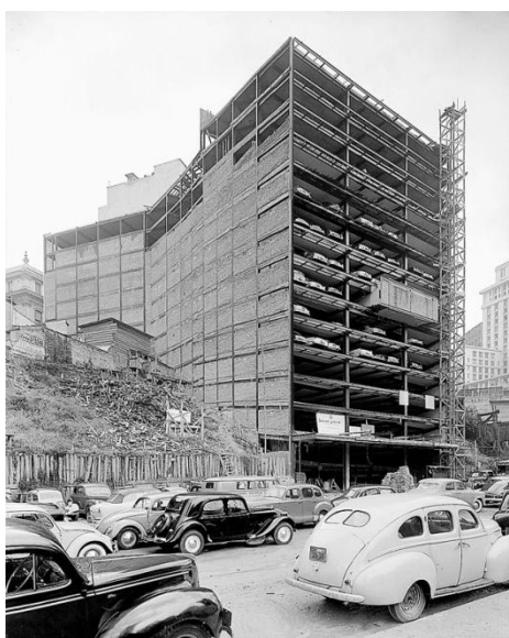
Figura 1: 1º Edifício em estrutura metálica no Brasil
