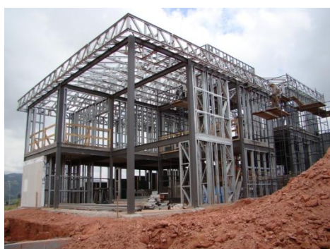
Figura 3: Estrutura Metálica com Stell Frame
