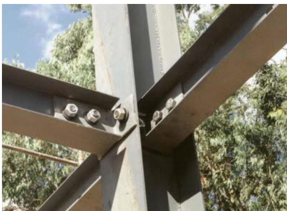
Figura 5: Fixação entre vigas e colunas
